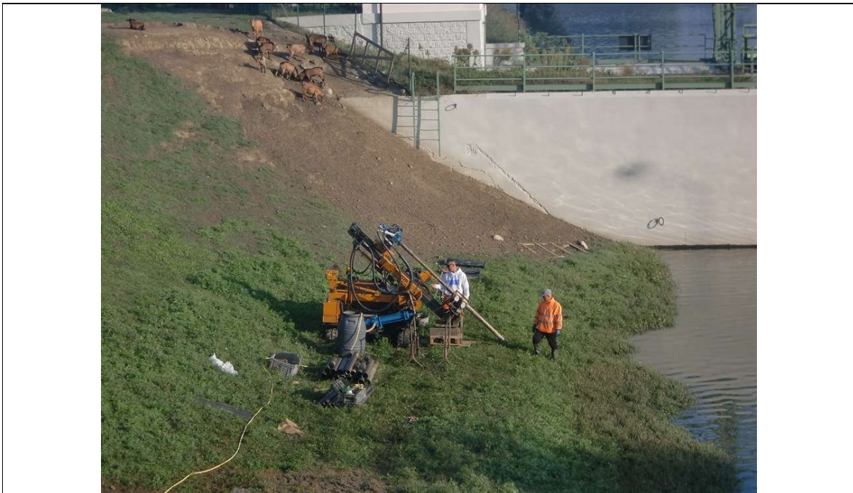
Figura 6 – Sondaggio inclinato SI2 (2017)
