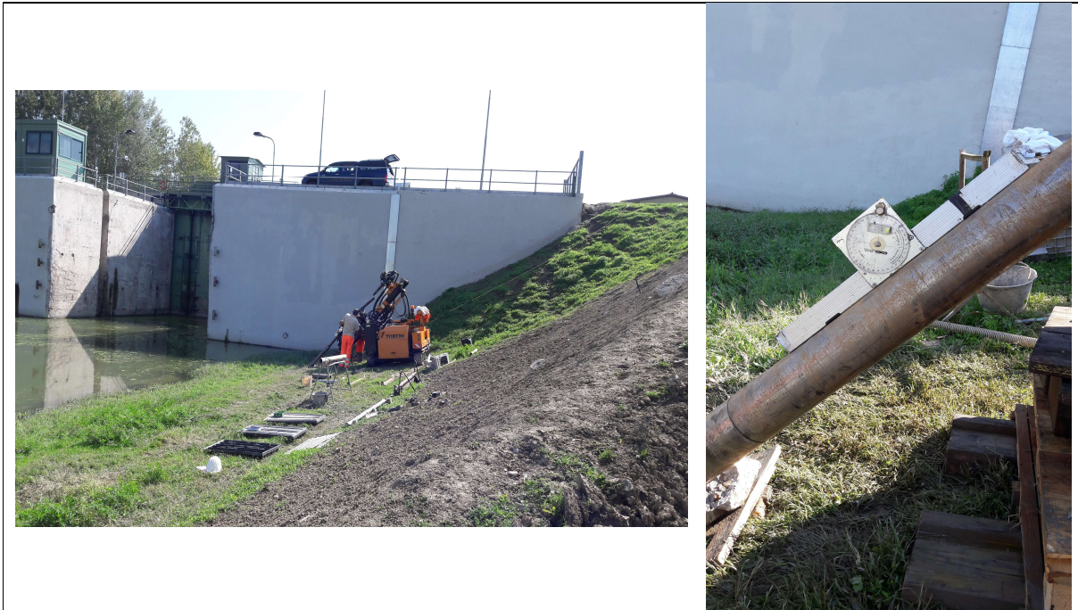
Figura 5 – Sondaggio inclinato SI1 (2017)
